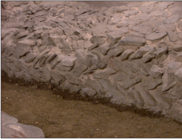
5. Katedra w Poznaniu, mur opus spicatum w masywie zachodnim. Fot. Z. Świechowski 2006-2010 5. Cathedral in Poznań, opus spicatum wall in Western edifice. Photo: Z. Świechowski 2006-2010
