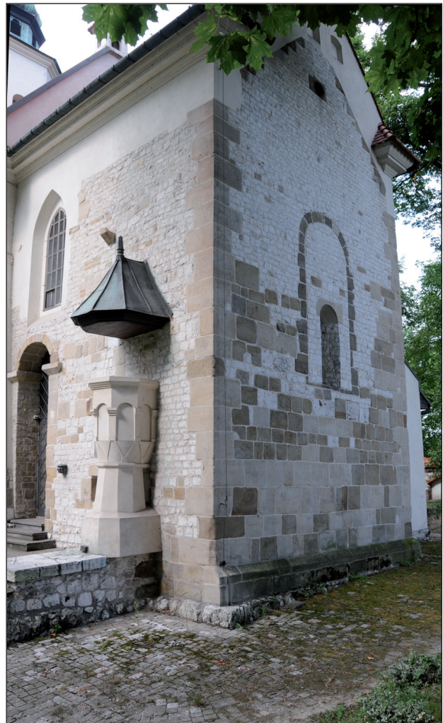
8. Kraków, kościół św. Salwatora, narożnik pld.-wsch. prezbiterium. Fot. Z. Świechowski 2006-2010
