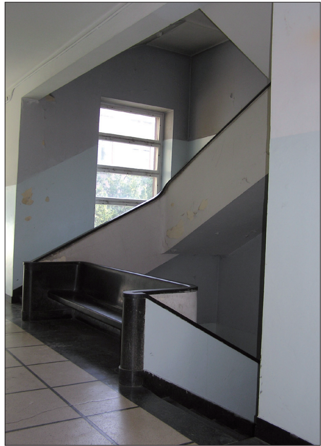
24. Gmach SGGW z końca lat 30., zaprojektowany przez Z. Wóycickiego. Detal klatki schodowej w połączeniu z kamiennym siedziskiem (stan sprzed remontu). Fot. Autorka, 2006 24. SGGW building from the end of thirties, designed by Z. Wóycicki. Detail of the staircase combined with a stone seat (before renovation). Photo: Author, 2006
