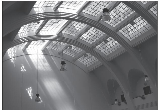
27. Wnętrze sali wykładowej w Pawilonie Doświadczalnym. Fot. Autorka, 2009
