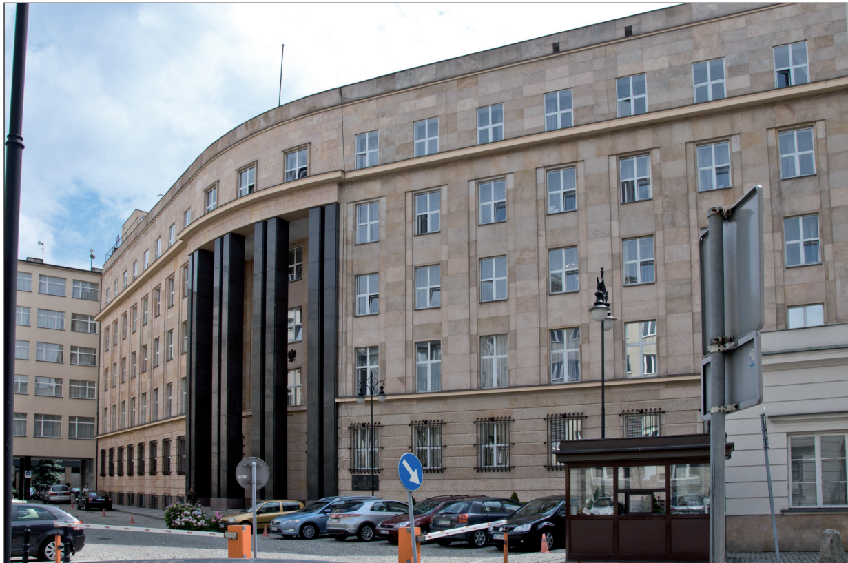
1. Warszawa, gmach d. Izby Przemysłowo – Handlowej przy ul. Senackiej, róg Wiejskiej, stan obecny. Fot. Autorka 1. Warsaw, the former Chamber of Industry and Commerce building on the corner of Senacka and Wiejska St., present day. Photograph: Author
