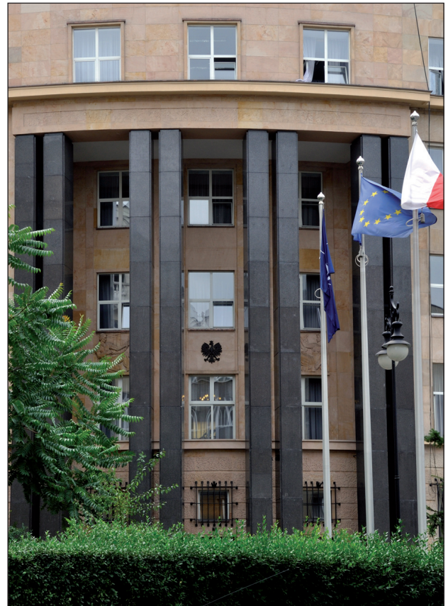
14. Warszawa, gmach d. Izby Przemysłowo - Handlowej w Warszawie przy ul. Senackiej, róg Wiejskiej – portyk wejścia głównego, stan obecny. Fot. Autorka
