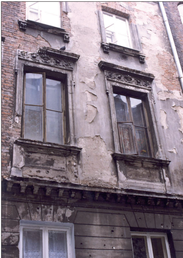
47. Okna w elewacji od podwórza kamienicy przy ul. Hożej 42 (1892-93). Fot. J. Roguska 2003
