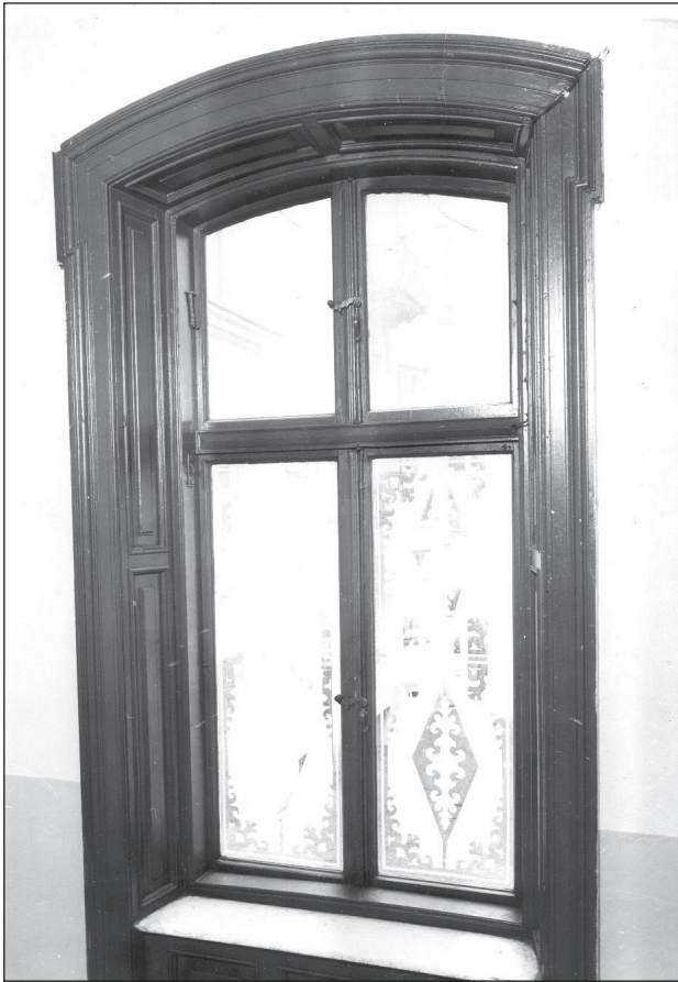
23. Okno klatki schodowej w kamienicy przy ul. Nowogrodzkiej 10. Fot. K. Kowalska, 1978 23. Window of the staircase in the tenement house at 10 Nowogrodzka St. Photo K. Kowalska, 1978
