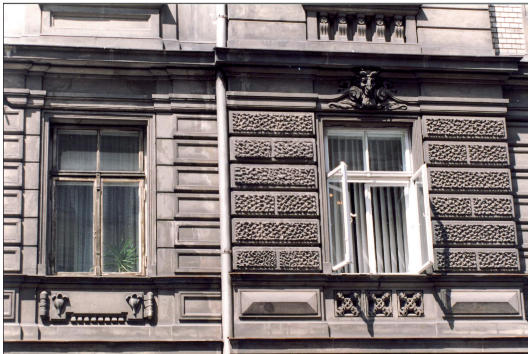
16. Okna kamienicy przy ul. Mokotowskiej 37/Koszykowej 24 (1901). Fot. J. Roguska 2003
