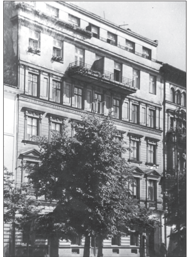
2. Kamienica w Alejach Jerozolimskich (dawniej 16, nie istnieje). Fot. 1937/38. AMWKZ, Zbiór Referatu Gabarytów 2. Tenement house at Aleje Jerozolimskie (formerly 16, does not exist). Photo 1937/38. AMWKZ, Volumetric Section collection
