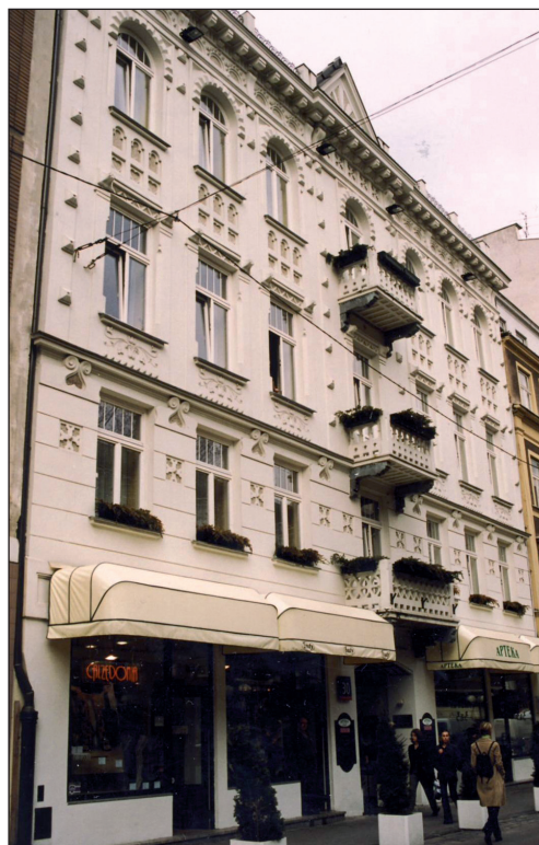
7. Fasada kamienicy przy ul. Chmielnej 30 po generalnym remoncie, z nowymi uchylnymi do wnętrza oknami, w barwie białej. Fot. J. Roguska 2003
