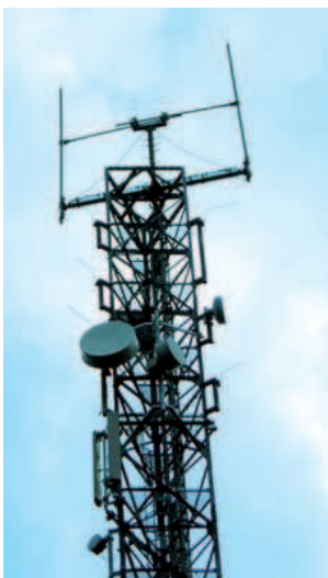
Fot. 1. Typowe anteny kierunkowe – źródła promieniowania w.cz. (wg [4])
