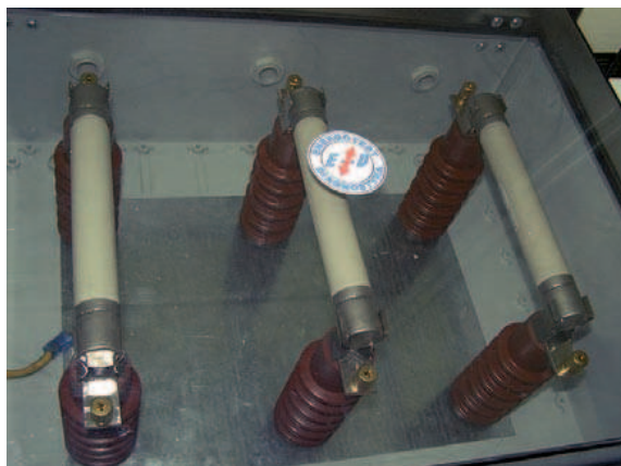
Rys. 4. Skrzynka bezpieczników średniego napięcia dla napięciowych sygnałów pomiarowych
