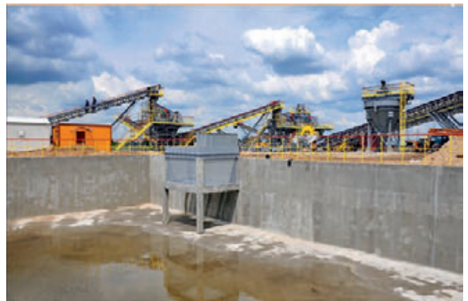
Fot. 3. Zakład Produkcji Kruszyw w Chabielicach Fot. 3. Processing plant in Chabielice
