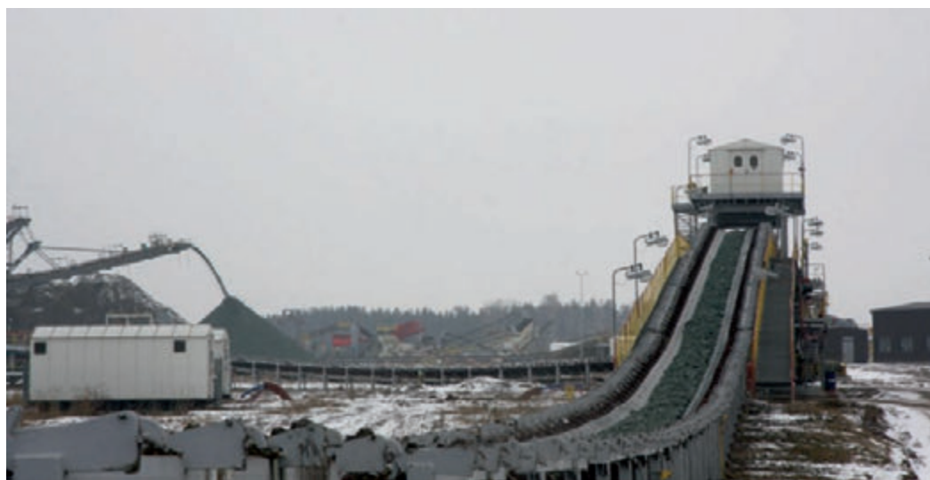
Fot. 5. Selekttywne składowanie ilów na składowisku kopalin towarzyszących Pola Szczerców Fot. 5. Selective storage of clays on the accompanying minerals dump in Szczerców Field
