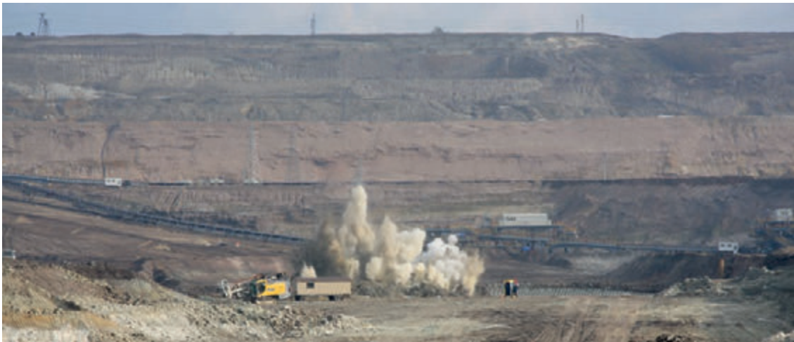
Fot. 3. Roboty strzałowe w rejonie występowania wapieni na zboczu północnym Pola Szczerców Fot. 3. Shooting in region of limestones occurrence on Szczerców Field north slope
