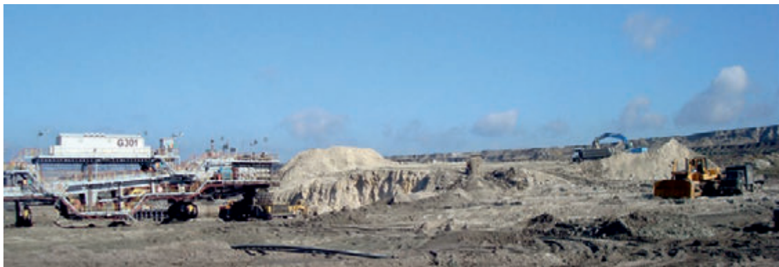
Fot. 5. Zagospodarowywanie wapieni na III poziomie w rejonie zbocza południowego Pola Szczerców Fot. 5. Limestones development on IIIrd level of Szczerców Field south slope
