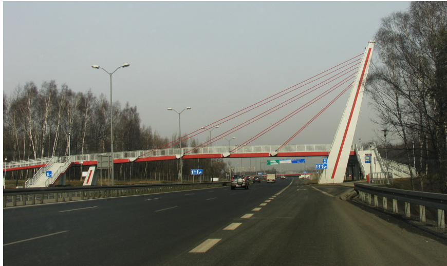
Rys. 8. Bezkolizyjne przejście dla pieszych
