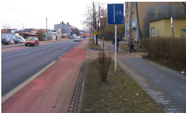
Rys. 9. Droga rowerowa Fig. 9. Cycle path
