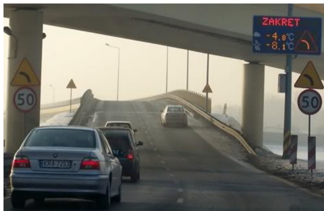
Rys. 4. Oznakowanie niekonwencjonalne Fig. 4. Unconventional road signs
