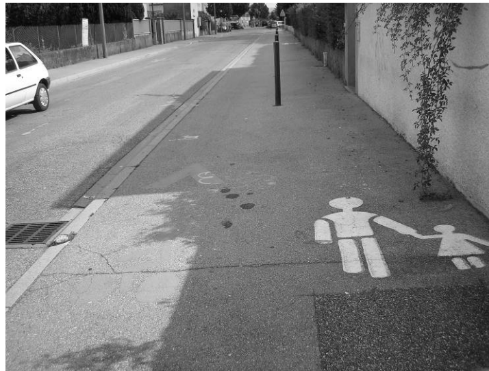
Fig. 2. The common path for cyclists and pedestrians – Grenoble Rys. 2. Grenoble – ciąg pieszo-rowerowy
