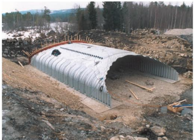
Rys. 2. Widok z góry na zmontowaną powłokę mostu wykonaną ze stalowych blach falistych przed zasypaniem jej gruntem
