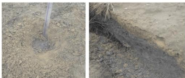
Fot. 1 i 2. Wykonana warstwa urodzajna o miąższości 12 cm (po lewej) i 8 cm (po prawej)
