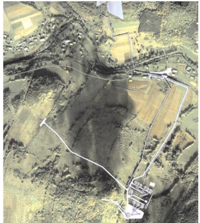
Rys. 7. Thumaczów-Gardzień – projekt zakładu przerobczego melafiru Fig. 7. Thumaczów-Gardzień - design of melaphyre processing plant
