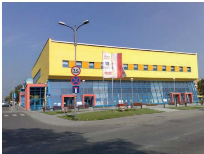
Fot. 9. Hala Widowiskowo-Sportowa po całkowitej termomodernizacji – elewacja południowa (fot. L. Malara)
