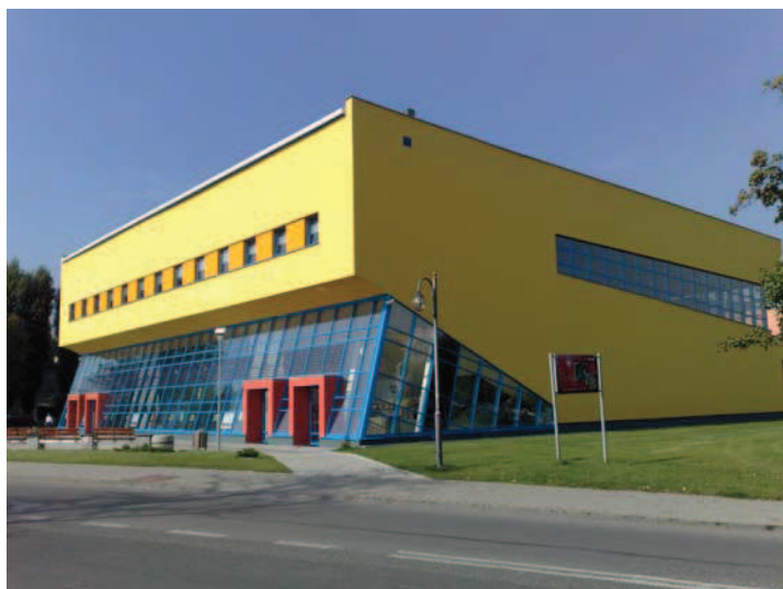
Fot. 8. Hala Widowiskowo-Sportowa po całkowitej termomodernizacji – elewacja południowo-wschodnia (fot. L. Malara)
