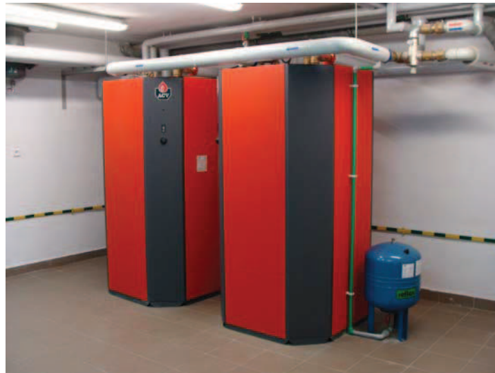
Fot. 3. Modernizacja dwufunkcyjnego węzła ciepłownego – system ciepłej wody użytkowej (fot. L. Malara) Photo 3. Modernization of the double-function heat distribution center – usable hot water system (photo. L. Malara)
