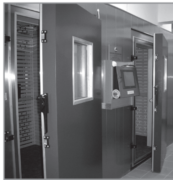
Fot. 14 Komora kriogeniczna w Szpitalu Pulmonologiczno-Reumatologicznym w Kup
