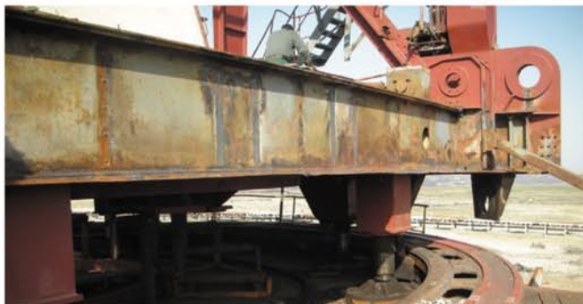
Rys.13. Platforma obrotowa przygotowana do wzmocnienia Fig. 13. Rotary platform prepared for strengthening
