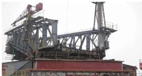
Rys. 10. Koparka nr fabryczny 345 po demontażu Fig. 10. Excavator, factory number 345 after disassembly
