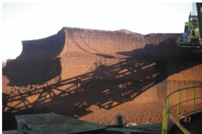
Rys. 18. Zmodernizowana koparka na froncie roboczym Fig. 18. Modernized excavator on working face
