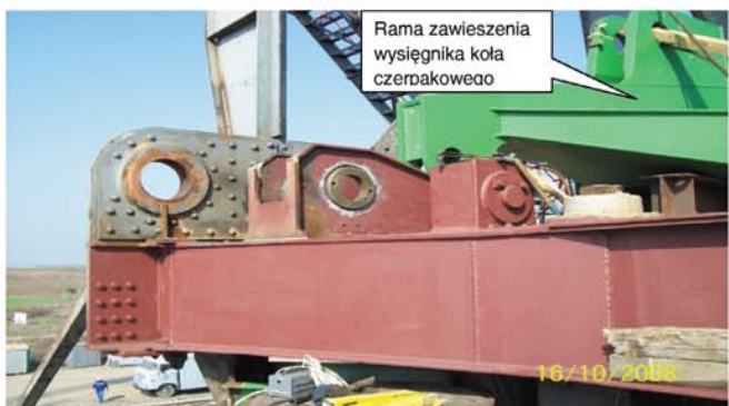
Rys. 14. Platforma obrotowa w trakcie wzmocniania Fig. 14. Rotary platform during strengthening
