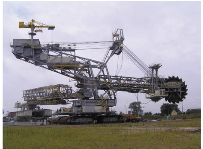
Rys. 3. Ogólny widok koparki SRs 1800
