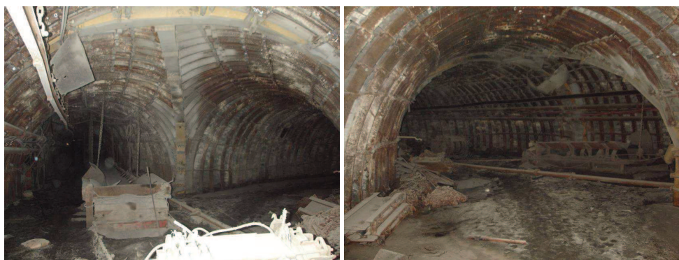
Fot. 2. Obudowa odgałęzienia przekopu zbiorczego na „S” poziom 700 m z objazdem wozów na „W”
