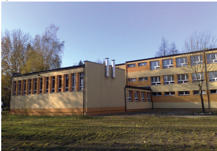
Fot. 2. Szkoła D – budynek po wykonaniu termomodernizacji: a – elewacja: południowa i zachodnia, b – elewacja: wschodnia i północna (fot. L. Malara)
