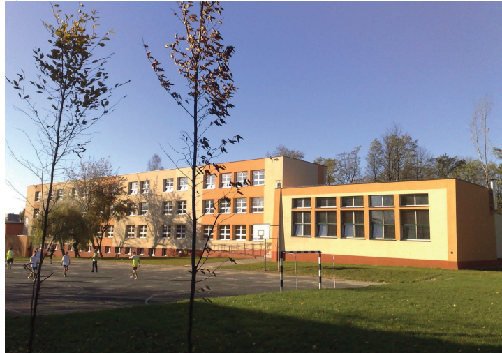
Fot. 1. Szkoła E – budynek po wykonaniu termomodernizacji: a – elewacja: wschodnia i południowa, b – elewacja: północna i wschodnia (fot. L. Malara)
