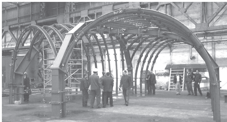
Fot. 5. Obudowa w czasie montażu próbnego (fot. M. Rotkegel)
