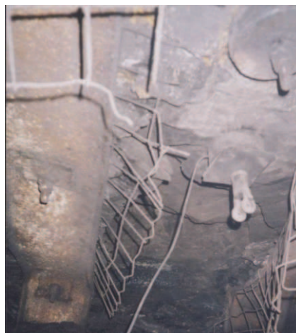
Fot. 1. Strop po odpaleniu 2,5 kg materiału wybuchowego w chodniku Z-1, pokład 413/1+2, kopalni „Jankowice”; na pierwszym planie: gumowy dynamometr krążkowy i geofon
