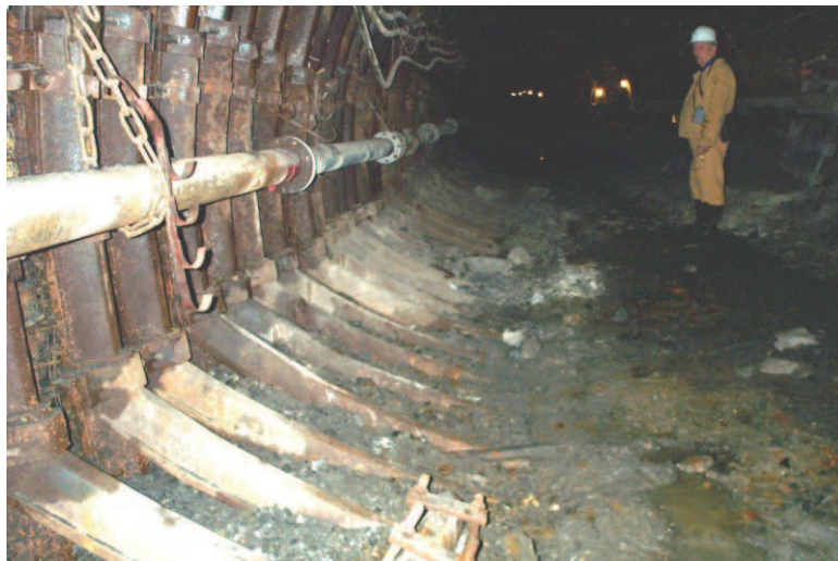
Fot. 2. Spąg chodnika polowego na odcinku z zabudowanymi spągnicami wykonanymi z kształtownika V36 ze stali o podwyższonych parametrach mechanicznych (brak deformacji)
