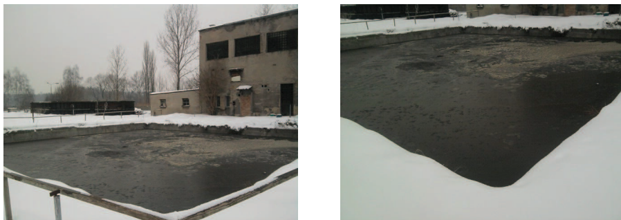
Rys.3.1. Zbiornik otwarty do magazynowania gnojowicy na terenie fermy (wyk. M. Czop).
