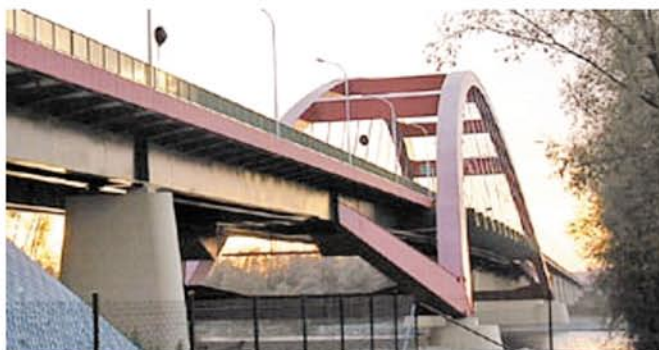
Rys. 5. Widok przęsła lukowego mostu w Puławach [3] Fig. 5 Arch bridge in Puławy [3]
