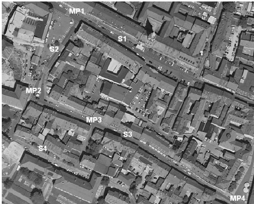
Fig. 1. City centre of Celje Рис. 1. Городской центр Целье
