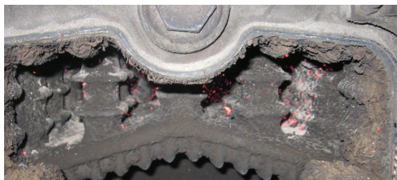
Fot. 1. Wypalanie sadzy na powierzchni wymiennika ciepła Photo. 1. Soot combustion on the surface of heat exchanger
