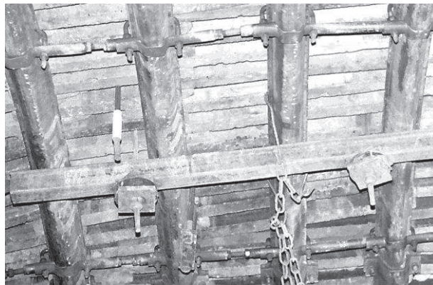
Fot. 1. Podciąg mocowany kotwiami strunowymi (fot. R. Daniłowicz) Photo 1. Stringer fastened by means of string bolts (photo R. Daniłowicz)
