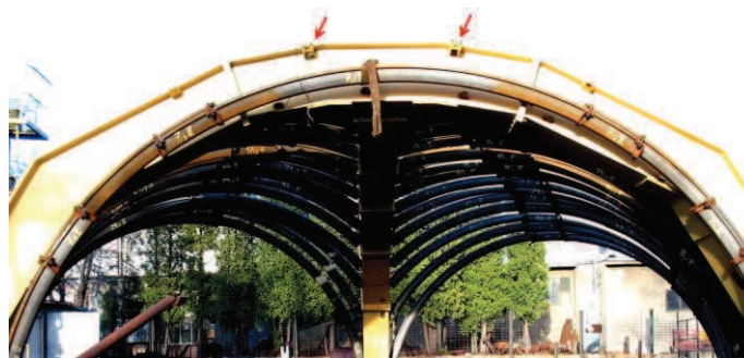
Fot. 2. Fragment konstrukcji obudowy odgałężenia z zaznaczonymi uchami do przykotwienia (fot. T. Dragon) Photo 2. Fragment of construction of roadway junction support with marked lugs for fastening (photo T. Dragon)
