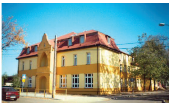
Fot. 1. Obiekt szkolny A – budynek I po wykonaniu termomodernizacji, poprawie sprawności systemu grzewczego i wymianie źródła ciepła (fot. L. Malara)
