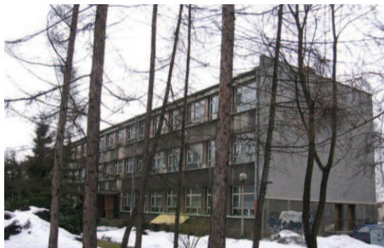
Fot. 4. Obiekt szkolny D przed wykonaniem termomodernizacji (fot. L. Malara)
