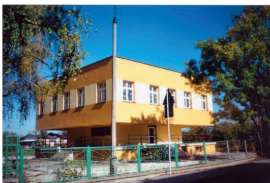
Fot. 1a. Obiekt szkolny A – budynek II po wykonaniu termomodernizacji, poprawie sprawności systemu grzewczego i wymianie źródła ciepła (fot. L. Malara)
