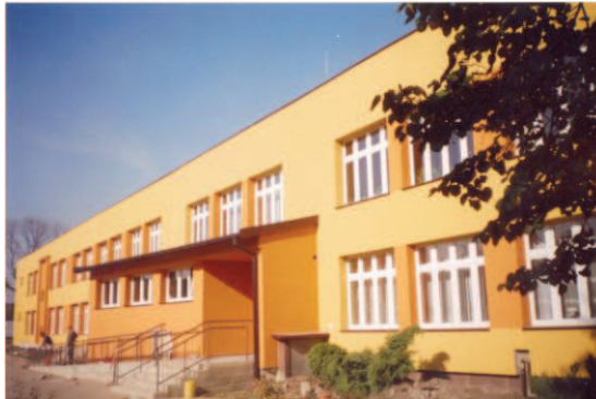
Fot. 3. Obiekt szkolny C po wykonaniu termomodernizacji, poprawie sprawności systemu grzewczego i wymianie źródła ciepła (fot. L. Malara)
