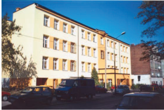
Fot. 2. Obiekt szkolny B po wykonaniu termomodernizacji i poprawie sprawności systemu grzewczego (fot. L. Malara)
