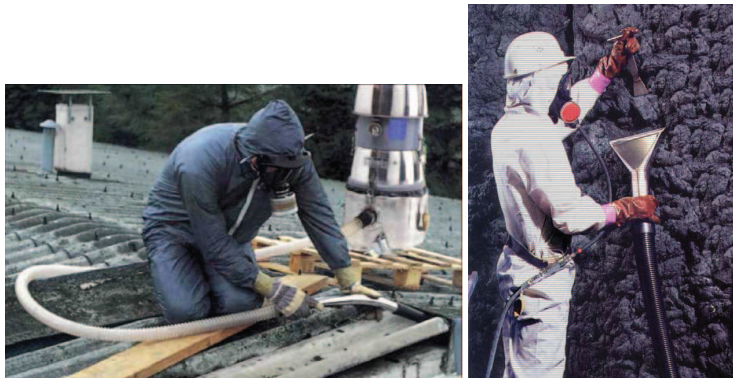
Fot. 1. Niemiecki przykład prawidłowego postępowania przy demontażu pokrycia dachowego z eternitu (odkurzacz z filtrem Hepa) i usuwania azbestu miękkiego (maska z nawiewem powietrza, specjalistyczny odkurzacz) (wykonywanie prac z azbestem – www.pip.gov.pl )
