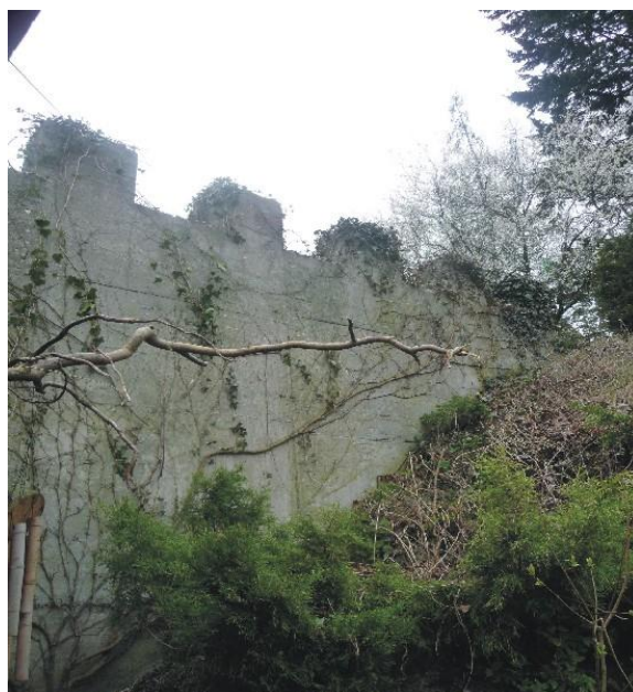
Fot. 1. Mur oporowy wykonany w celu wzmocnienia zbocza przy ul. Braniborska – Władysława IV
