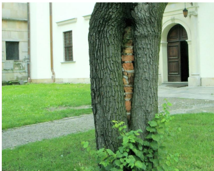
Fot. 8. Popularna niegdyś technika zamurowywania dziupli (fot. Aung 2009) Phot. 8. Popular technique of bricking up the tree hollows (phot. Aung 2009)
