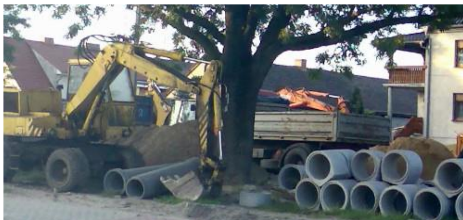
Fot. 6. Wadliwie zabezpieczone drzewo: postój, składowisko i brak osłony pnia. Gosławice (fot. EkoOpole 2009)
