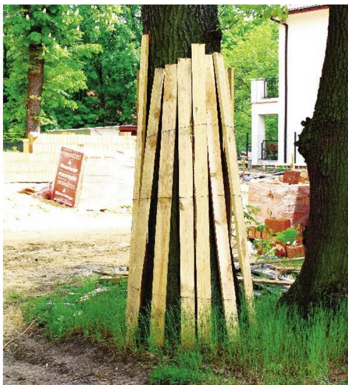
Fot. 4. Drzewo na placu budowy, nieodpowiednio zabezpieczone przed uszkodzeniami przy pomocy desek (fot. Greg 2010)
