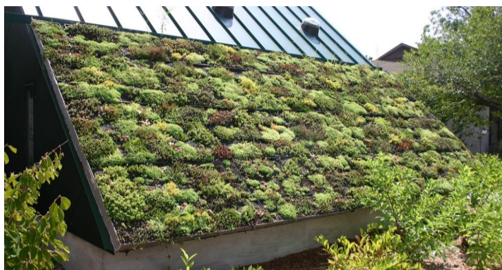
Fot. 4. Przykład dachu ekstensywnego – Virginia Living Museum (fot. Somma 2002) Phot. 4. An example of extensive roof garden – Virginia Living Museum (phot. Somma 2002)
