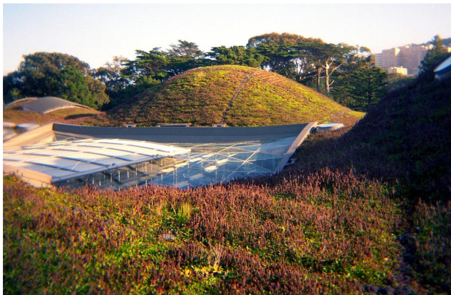
Fot. 1. Przykład zielonego dachu z urozmaiconą rzeźbą terenu – San Francisco (fot. www.flicker.com 2009)
