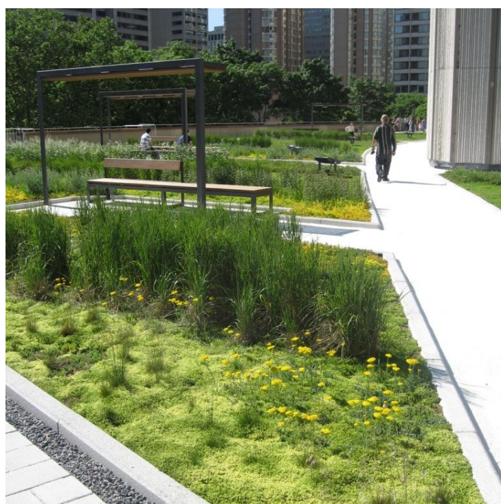
Fot. 5. Przykład dachu intensywnego – City Hall Toronto (fot. Padraic 2002) Phot. 5. An example of intensive roof garden – City Hall Toronto (phot. Padraic 2002)
