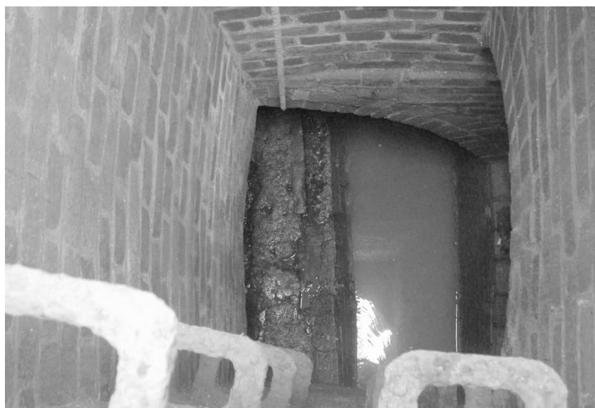
Fot. 1. Przelew burzowy PB-1 – ul. P. Skargi Phot. 1. Overflow structure PB-1 – P. Skargi street
