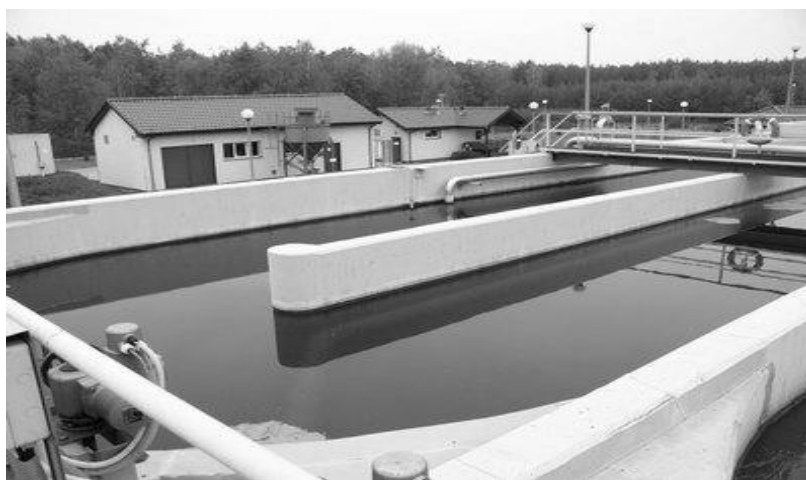
Fot. 1. Widok na oczyszczalnię ścieków Phot. 1. Wastewater treatment plant
