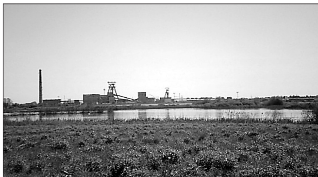
Rys. 3. Wypełniona wodą niecka osiadań w Szczecinie koło Bogdanki. Fot. Autorka Fig. 3. Subsiding trough Szczecin near Bogdanka mine felt in with water. Fot. by Author
