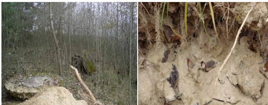
Rys. 2. Widok na studnię nr 2 i nr 3 mogilnika oraz niezaizolowany dół ziemny z odpadami pestycydowymi w Folwarkach Tylwickich
