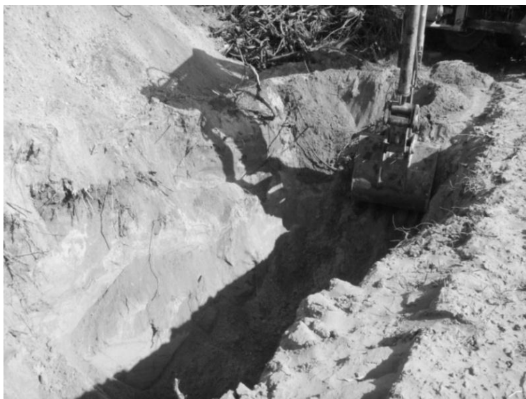
Rys. 9. Wykop pod barierę Fig. 9. Excavation for barrier
