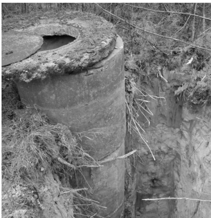
Rys. 3. Zdjęcie odkrywki studni nr 1
