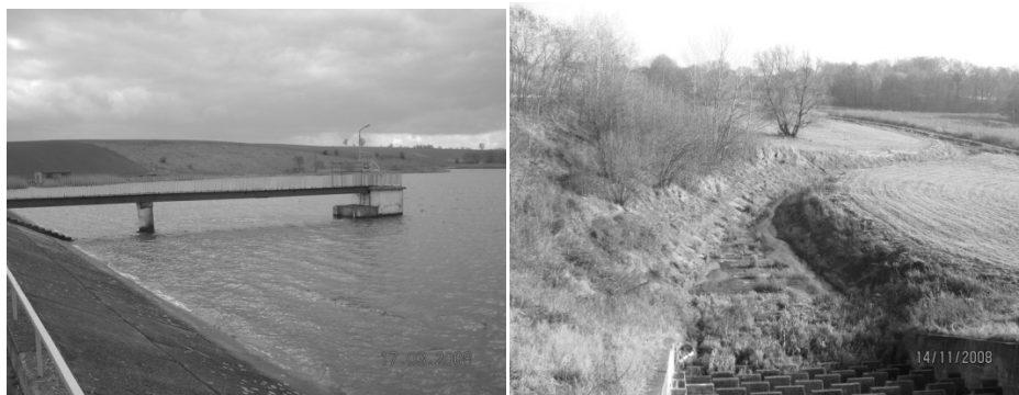
Rys. 2. Zbiornik Nowaki – zapora zbiornika i upust wieżowy (po lewej) i przelew powodziowy stokowy z bystrzem (po prawej)
