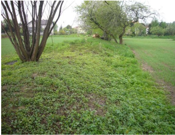
Rys. 3. Wał przeciwpowodziowy, km 18,130÷18,230 biegu rzeki Piotrówki Fig. 3. A dike in 18,130÷18,230 km of Piotrówka river
