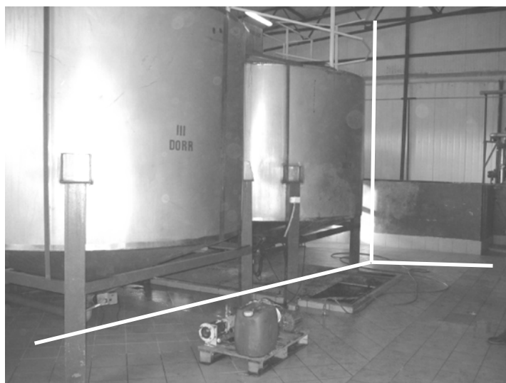
Rys. 10. Osadniki typu Dorra nr III i V w hali podczyszczania ścieków firmy SUPERFISH – strefa przeprowadzonych badań
