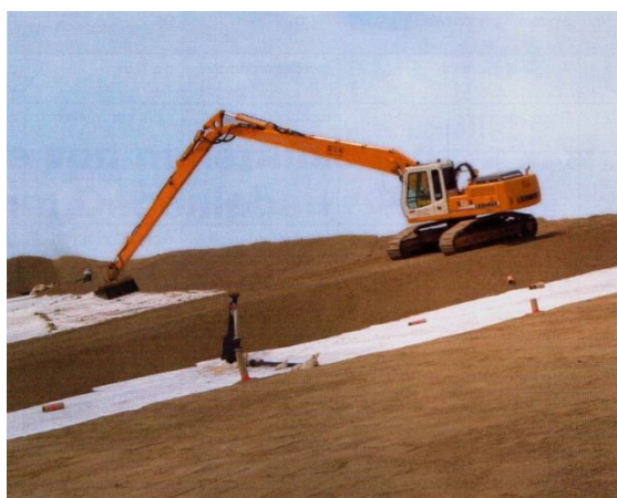
Fot. 1. Budowa kwatery w składowisku odpadów komunalnych
