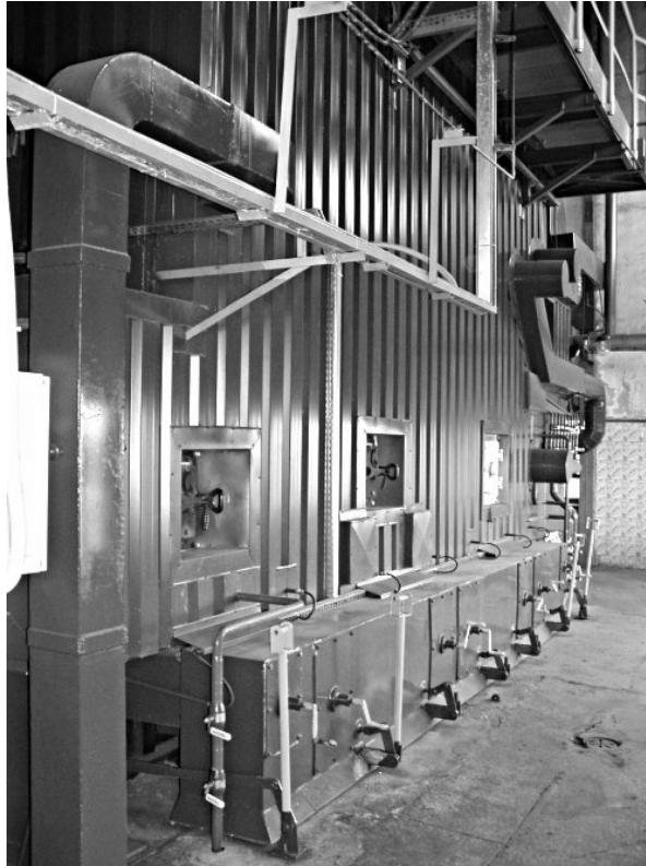
Rys. 2. Kocioł WR-25 na paliwo stałe z wielostrefowym doprowadzeniem powietrza Fig. 2. Solid fuel boiler WR-25 with distributed input of air
