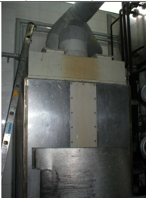
Rys. 5. Filtr sorpcyjny z węglem aktywnym
