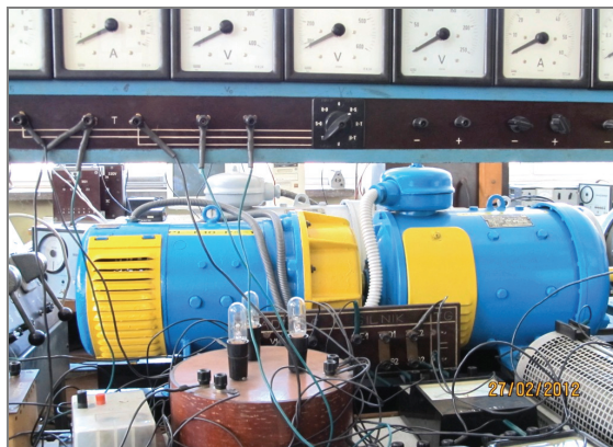
Rys. 1. Widok zespołu maszynowego złożonego z prądnicy synchronicznej i silnika prądu stałego Fig. 1. View of the machine set consisting of synchronous generator and DC motor
