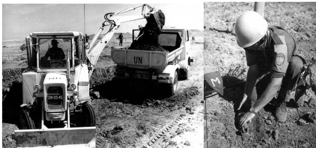
Rys. 1. Remont drogi i usuwanie niewybuchów przez polskich saperów na Półwyspie Synaj
