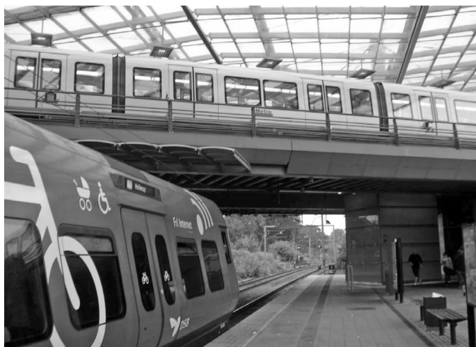
Fot. 2. Stacja Flintholm, węzeł metra i kolei podmiejskiej (fot. Adam Radzimski).
