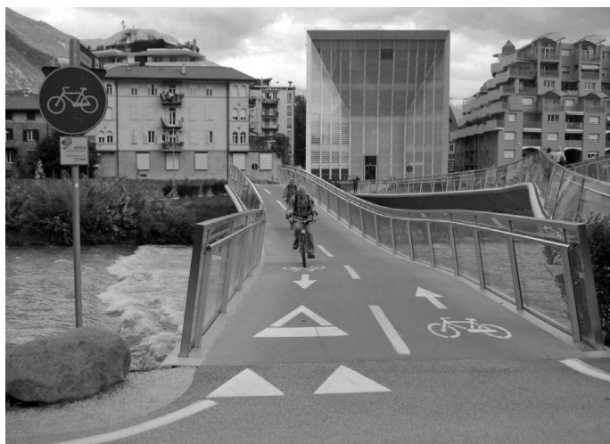
Fot. 2. Mosty rowerowe i piesze (na prawo od mostu rowerowego) wyróżniają się szczególną estetyką rozwiązań (fot. Michał Beim).
