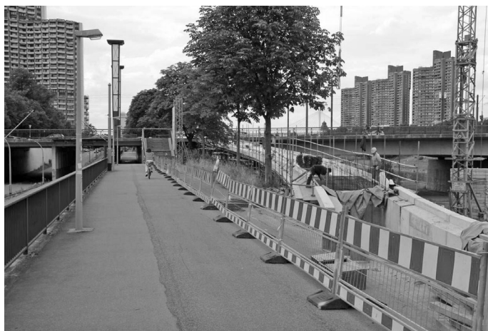
Fot. 3. Budowa rampy łączącej drogę dla pieszych i rowerzystów biegnącą wzdłuż Neckaru z mostem, fot. Michał Beim.
