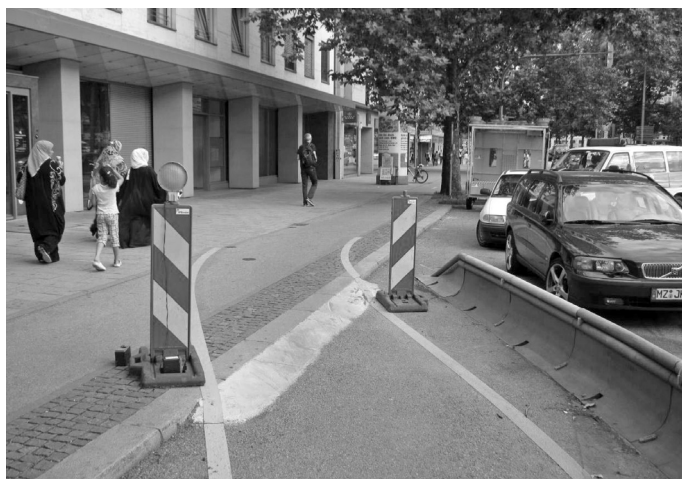
Fot. 4. Objazd dla rowerów remontowanego fragmentu chodnika i drogi rowerowej odbywa się kosztem zajęcia jednego z pasów ruchu (fot. Michał Beim).
