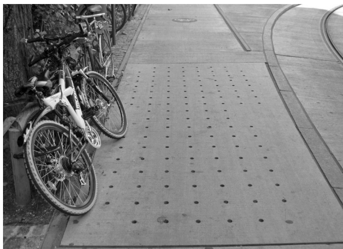
Fot. 1. Specjalna płyta betonowa w okolicy drzewa zapewnia ochronę systemu korzeniowego, jednocześnie – przez sposób realizacji – nie stanowi pogorszenia warunków jazdy rowerem (fot. Michał Beim).
