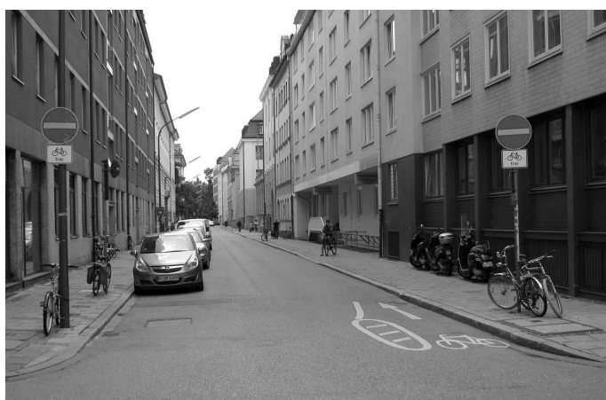
Fot. 8. Krótka droga rowerowa przy skrzyżowaniu ulicy jednokierunkowej z dopuszczonym ruchem rowerowym pod prąd (Monachium) ma zapobiegać blokowaniu rowerzystów przez pojazdy skręcające w lewo (fot. Michał Beim)
